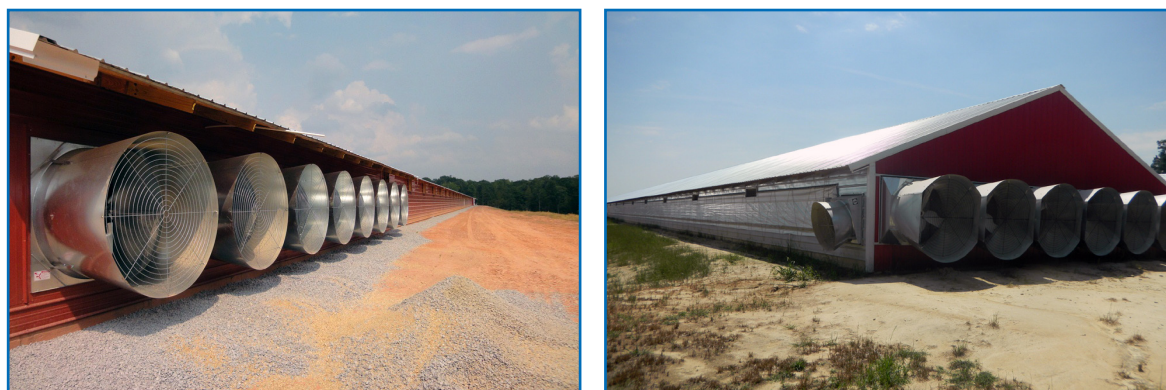
Figura 40: Exemplo de típico galpão ventilado por túnel.
