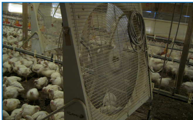
Figura 29: Ventiladores de circulação em um galpão naturalmente ventilado.
