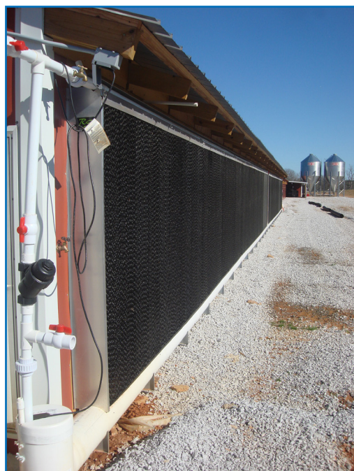
Figura 45: Exemplo de painel de resfriamento instalado na parede lateral do galpão (no “doghouse”).
