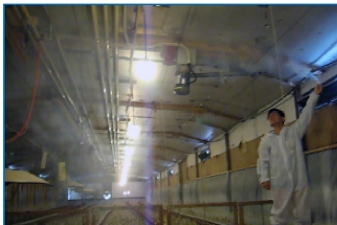
Figura 34: Uso do teste de fumaça para determinar se o fluxo de ar e a pressão operacional estão corretos.
