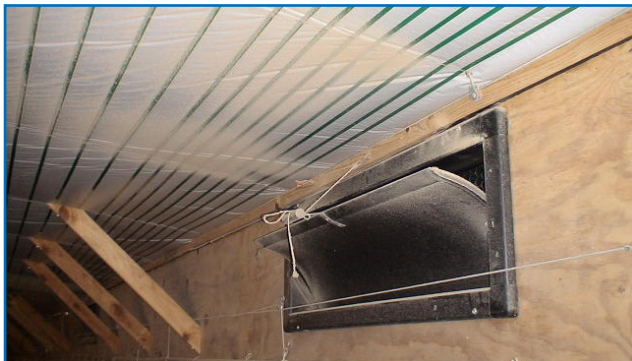
Figura 36: Exemplo de entrada de ar de boa qualidade.
